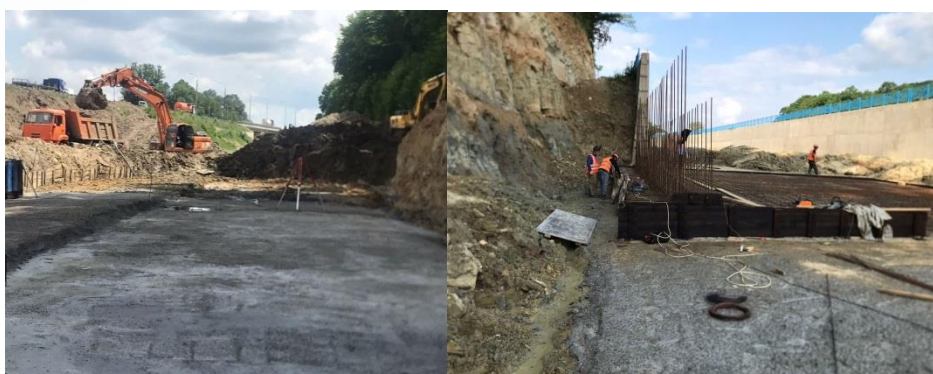
Рисунок 7.1.167 – Плановые работы на объектах капитального строительства
