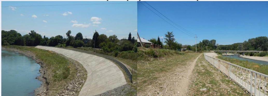
Рисунок 7.1.174 – Мониторинг гидротехнических сооружений
