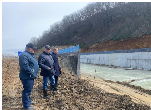
Рисунок 7.1.151 – Инспектирование объекта инженерной защиты территории Крымского района
