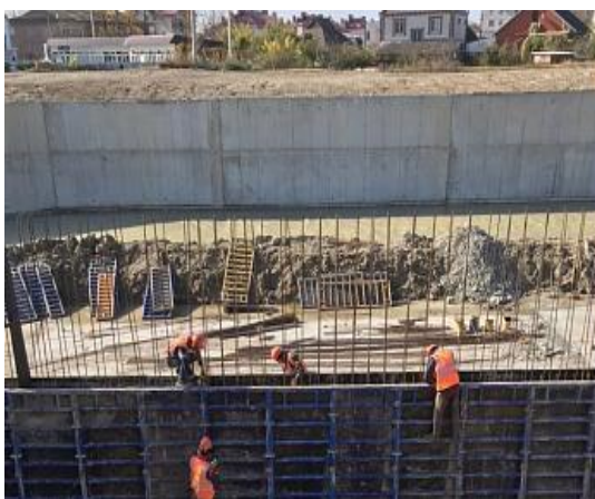
Рисунок 7.1.69 – Продолжение работ по строительству железобетонного лотка в русле реки Адагум
