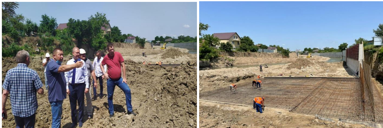
Рисунок 7.1.56 – Оценка строительно-монтажных работ по берегоукреплению р. Адагум в г. Крымске
