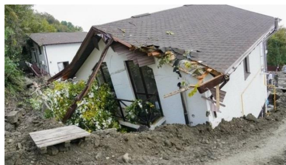
Рисунок 3.4.7 – Смещение жилого дома в коттеджном посёлке с. Сергей-Поле, г-к. Сочи 6 октября 2021 г.
