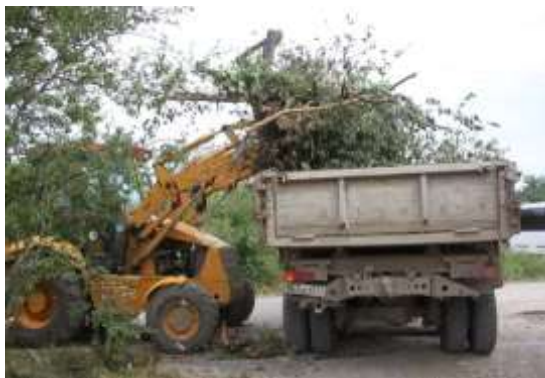
Очистка территорий от поросли
