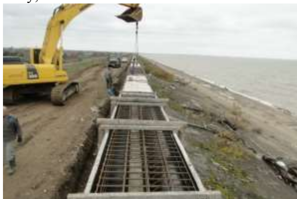
Рисунок 3.4.13 - Берегоукрепительные работы Краснодарского водохранилища
