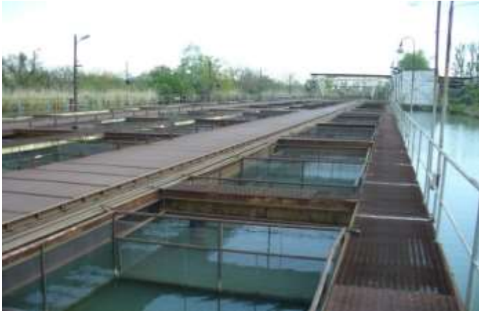
Рисунок 2 - Тепловодный канал (Солнечный остров)
