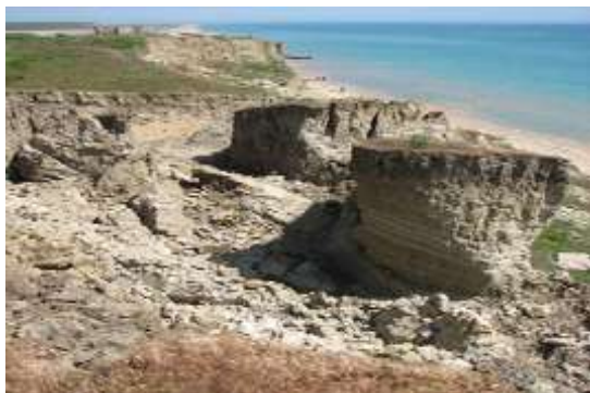
Рис. 1.3.2. Обвальнo-оползневые процессы у мыса Железный Рог Таманского участка
